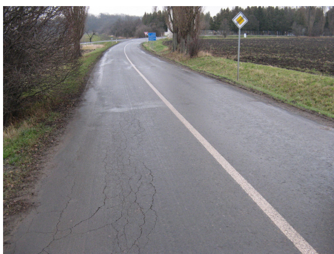
F43, km 30,910 síťové trhliny, plošné deformace
