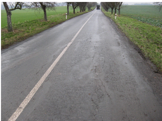
F21, km 29,610 rozvětvené podélné trhliny
