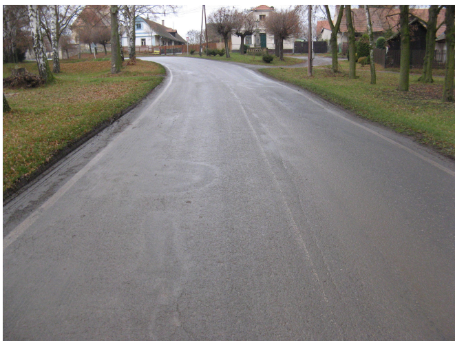
F10, km 28,990, v obci Bošín síťové trhliny a plošné deformace vozovky
