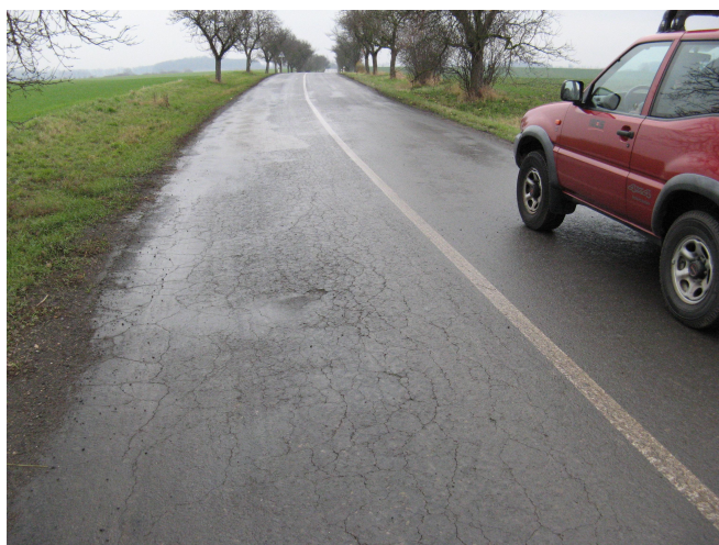
F20, km 29,520 síťové trhliny a plošné deformace
