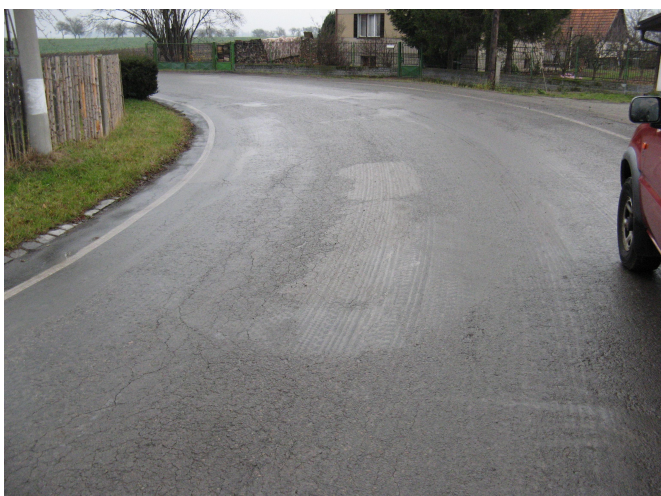
F17, km 29,300, v obci Bošín síťové trhliny a plošné deformace
