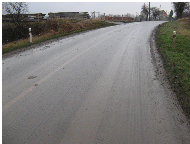
F04, km 28,510 síťové trhliny, vozovka silně znečištěná stavebním provozem
