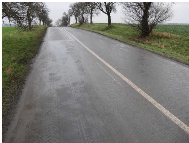
F25, km 29,810 síťové trhliny
