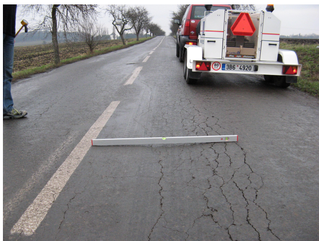
F34, km 30,390 síťové trhliny a plošné deformace
