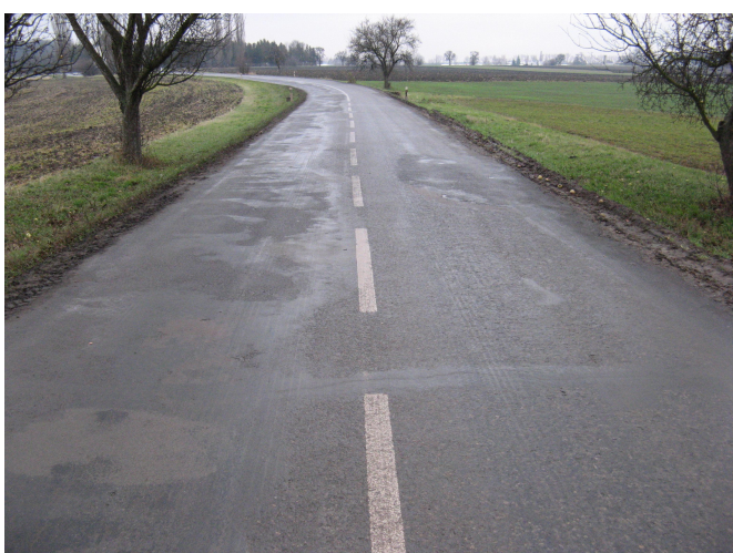
F39, km 30,710 příčná rozvětvená trhlina vpravo, vlevo síťové trhliny, vysprávkky, nepravidelné hrboly
